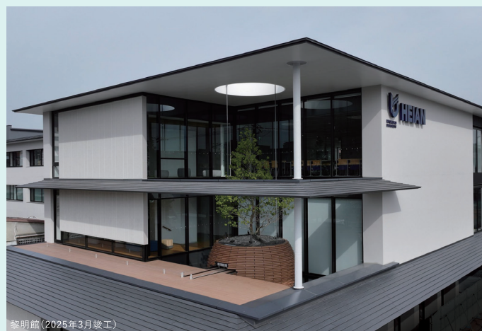
黎明館(2025年3月竣工)
